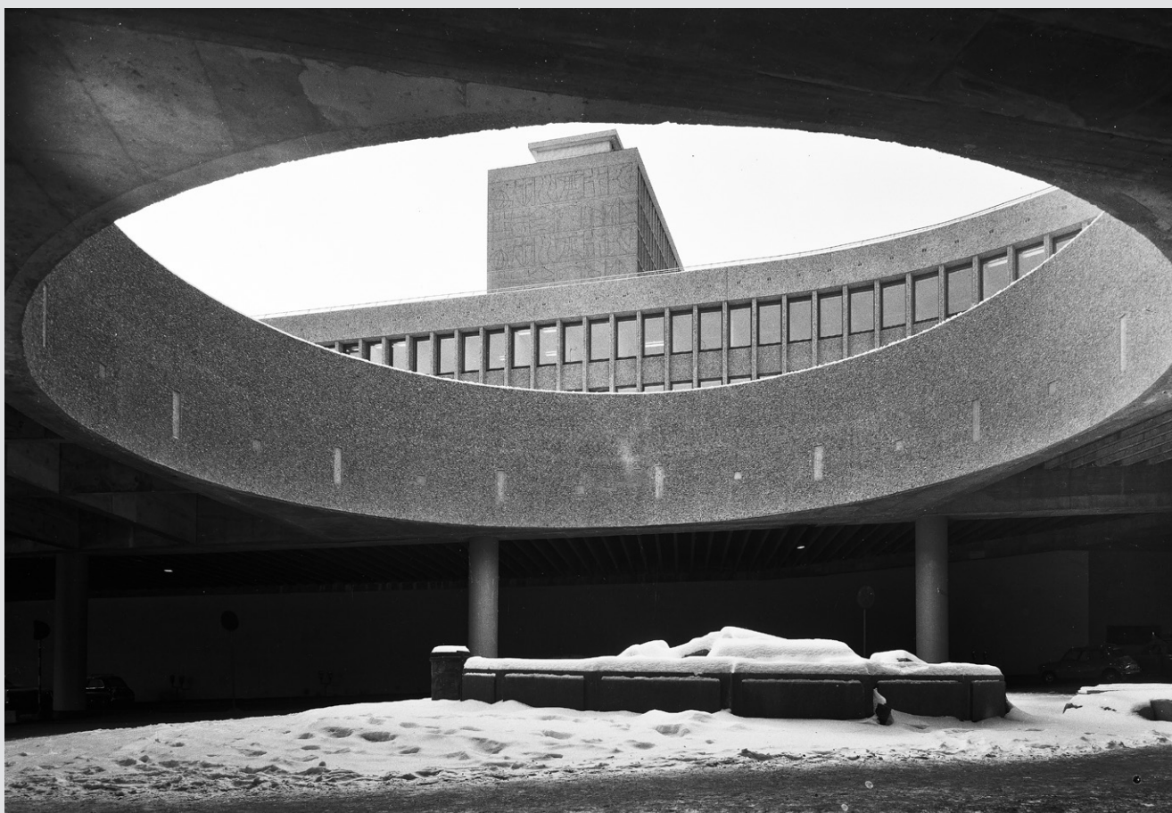
Sett fra Hammersborgtunnelen. Digitalmuseum.no: © Teigens Fotoatelier/DEXTRA Photo
