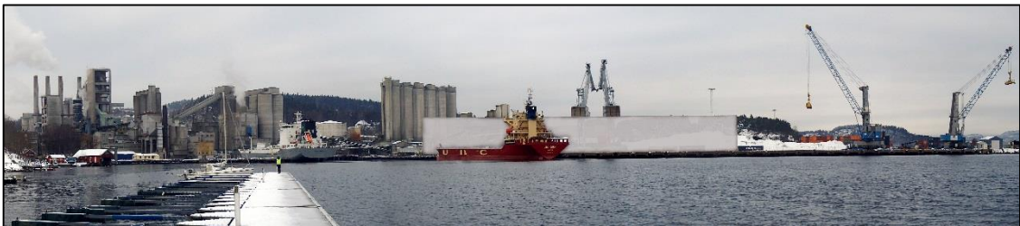
Figur 8.2b: Tiltaket sett fra småbåthavnen på Setrelandet, punkt 1 (se fig. 8.1). Illustrasjonen viser maksimal størrelse på nytt kalksteinslager.
