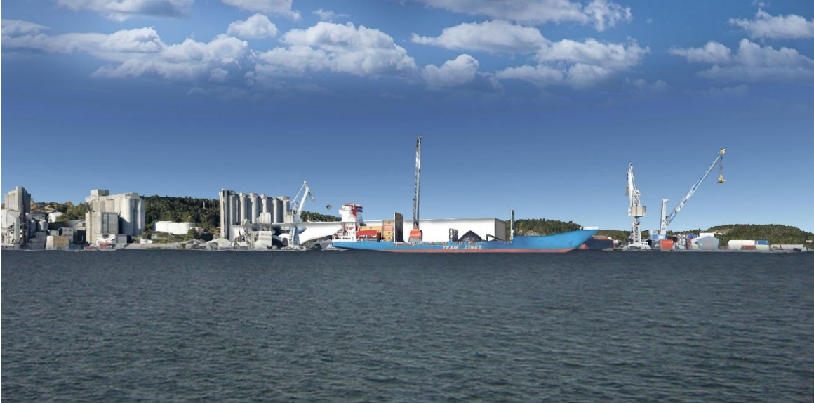
Figur 8.7: Illustrasjon av fjernvirkningen sett fra sjøen utenfor Setrelandet (se fig. 8.6, punkt 5). Hvit farge er valgt for å få synlighet.
