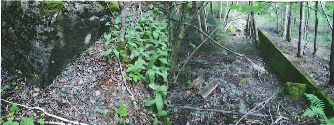
Figur 12. En del steder der det ved første øyekast kunne se ut til å være naturlig skogbunn kunne man avdekke tykke lag med påført pukkstein under vegetasjonen (venstre). Andre steder var det veldig tydelig at det var gjort inngrep (høyre).
