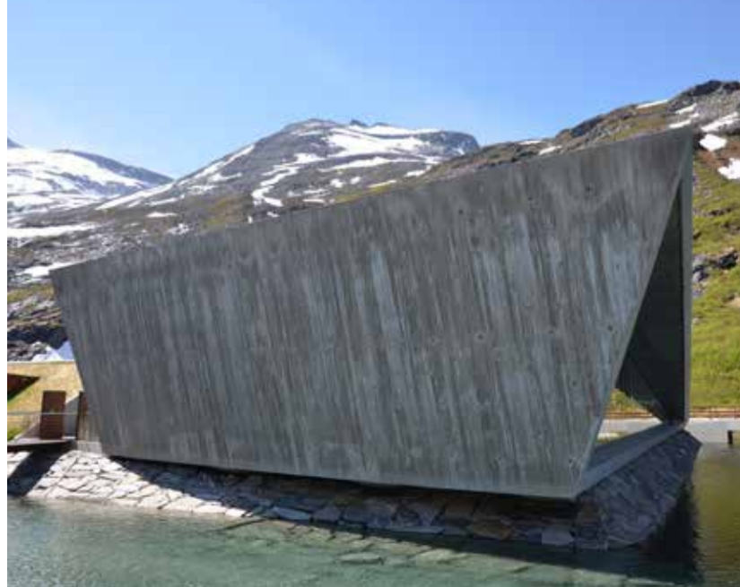
Det nye turistanlegget i Trollstigen fikk utmerkelsen Betongtavlen for sin bruk av betong.
