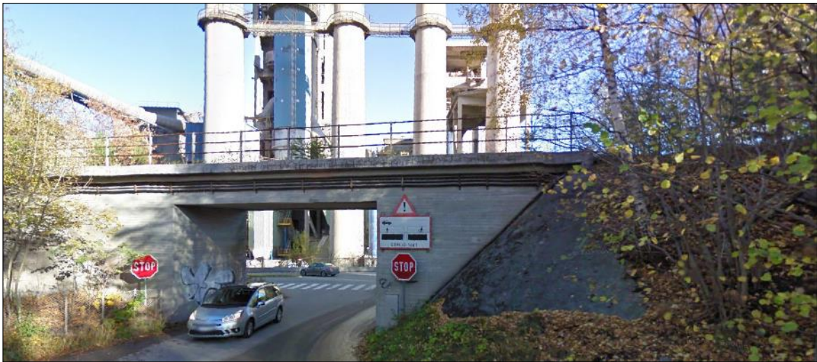
Bilde 6: Kryss Hillsveg/Breviksvegen sett mot øst. Kilde: Google.no
